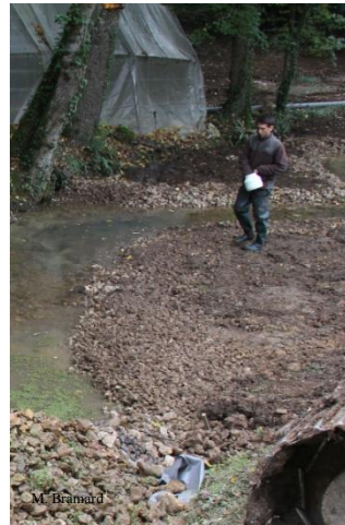
Semis manuel dès la fin des travaux
