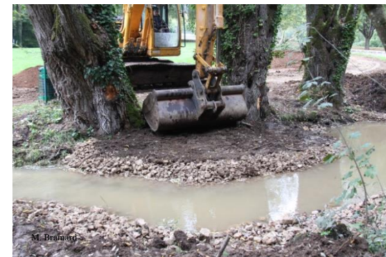
Pose de terre derrière un cordon pierreux
