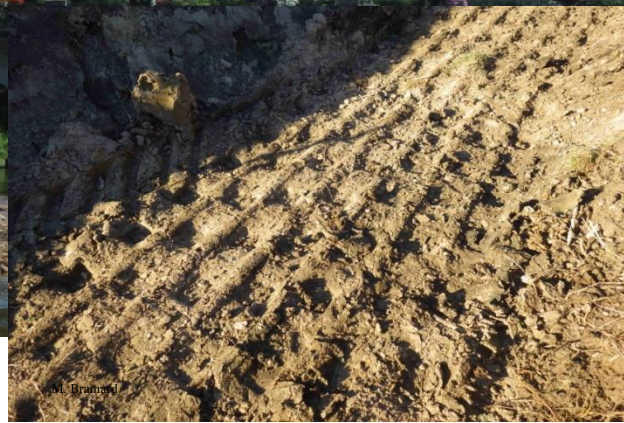
Terre argileuse compactée au «Pied-de-mouton»
