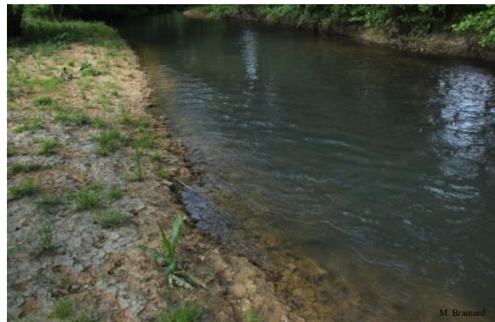
Exemple de redressement de la bordure d'une banquette en matériau très cohésif (argile)
