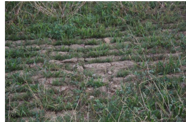
Crénelage d'un talus perpendiculaire à la pente pour favoriser la reprise du semis
