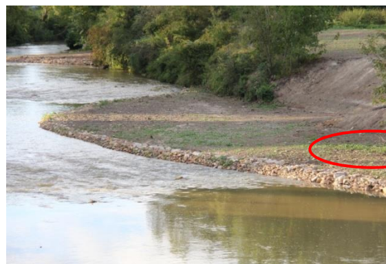
érosion localisée au droit d'une aspérité
