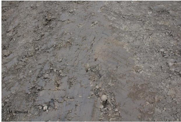
Terre lissée au godet : peu favorable à la prise d'un semis herbacé
